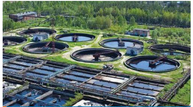
Xử lý nước thải và HVAC
